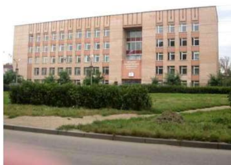
Административное здание (с 1989 г.) (ул. Высоковольтная, 9)
